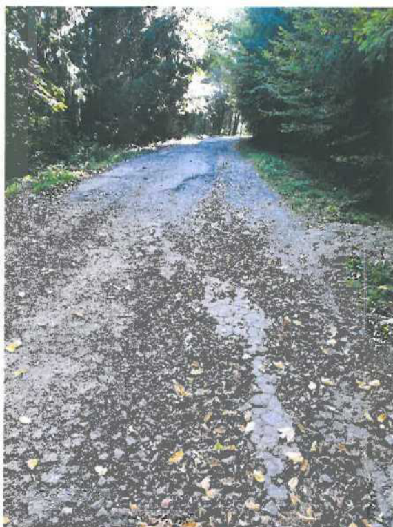
Foto 3 a 4: Střední úsek cesty (kolem jezírek) – degradace konstrukce PM
